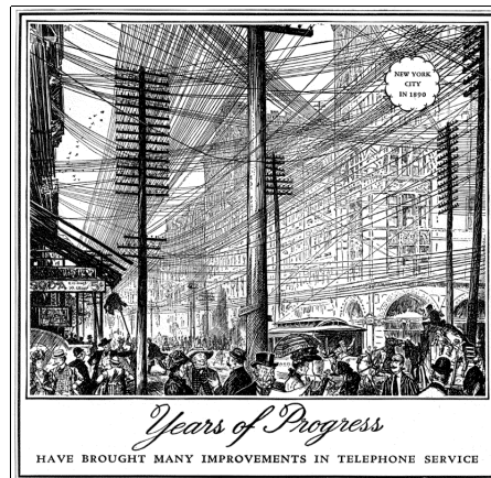
FIGURE 1.2 – Enchevêtrement sauvage de fils téléphoniques
